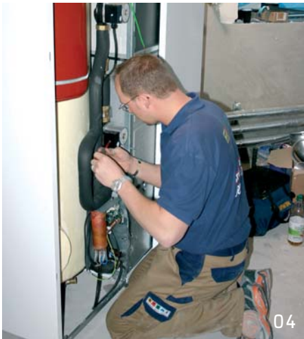
04+05 Heiko Mietschke installiert die Wärmepumpe | 06 Anlieferung der Wärmepumpe | 07 Luftkanalführung zum Integralgerät. Die Wandheizung (rechts) sorgt für wohlige Wärme in der Mühle | 08 So sieht das Integralgerät LWZ 403 SOL für Heizung, Lüftung und Warmwasser fertig installiert am Ende aus
